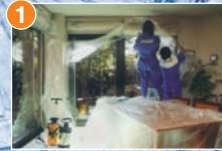
「水を大量に使うため、窓周りはしっかりカバーします」
