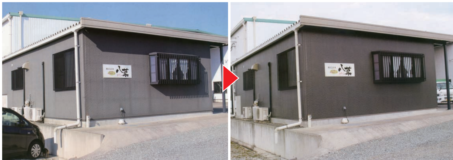
某居酒屋外観再生
